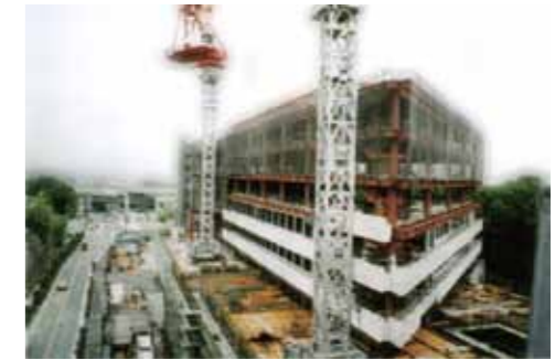
平成6年柴原町に新病院建設工事スタート
